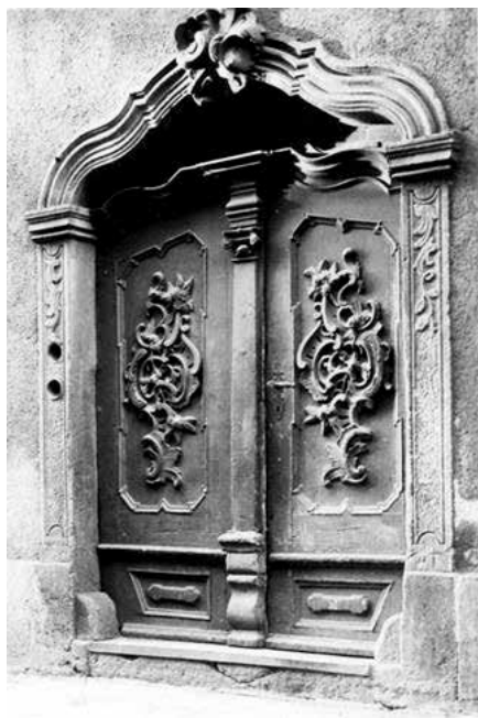
Ryc. 14. Portal kamienicy przy ul. Drucianej 3, fot. przed 1945, WUOZ.JG
