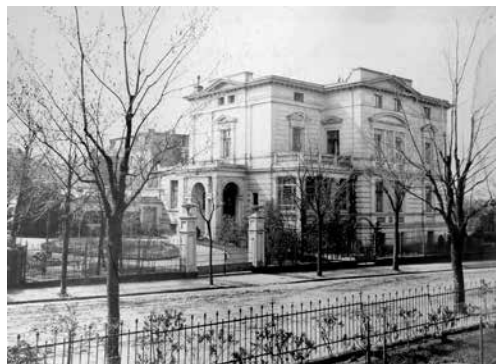
Ryc. 5. Budynek Norwida 9 ok. 1900 r.
