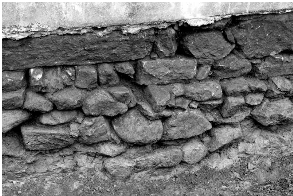
Ryc. 11. Kamienne fundamenty kościoła
