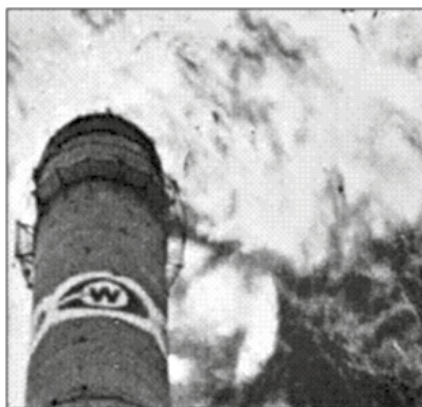
Ryc. 9. Pożar 152 m komina wentylacyjnego przyspieszył koniec produkcji włókien w „Celwiskozie”
